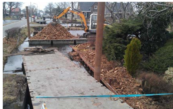
Fig. 7. Aanbrengen van 'schors': een lichte en goedkope vulling voor achter de damwand. Foto: A.J.P. Koot.
